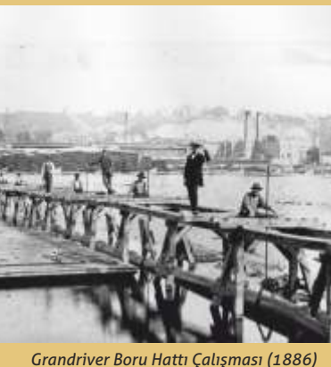
Grandriver Boru Hattı Çalışması (1886)
